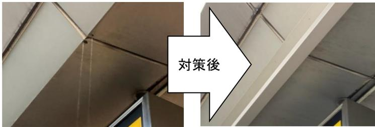
豪雨時に刈谷駅構内のあちこちで雨漏りが生じる問題を指摘した結果、応急処置として、北口通路の軒先(左図)と通路下の男子トイレに、漏れ出した雨水を受け止める雨樋(あまどい)が新設されました。今後始まる雨漏りの原因調査で、雨水が入り込む場所や流れるルートが解明できれば、恒久的対策につながりますので、動向を注視していきたいと思えます。
