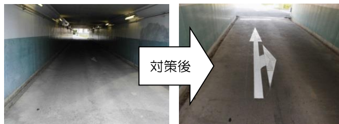
消失した路面表示の再施工(一ツ木町)
